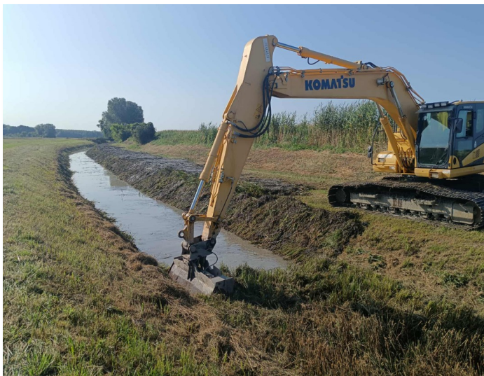
Bogyisló főcsatorna — Gyökérzónás mederkotrás
