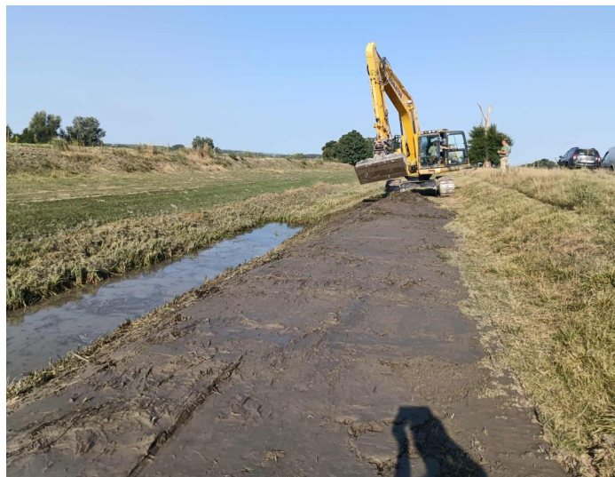
Bogyisló főcsatorna — Gyökérzónás mederkotrás
