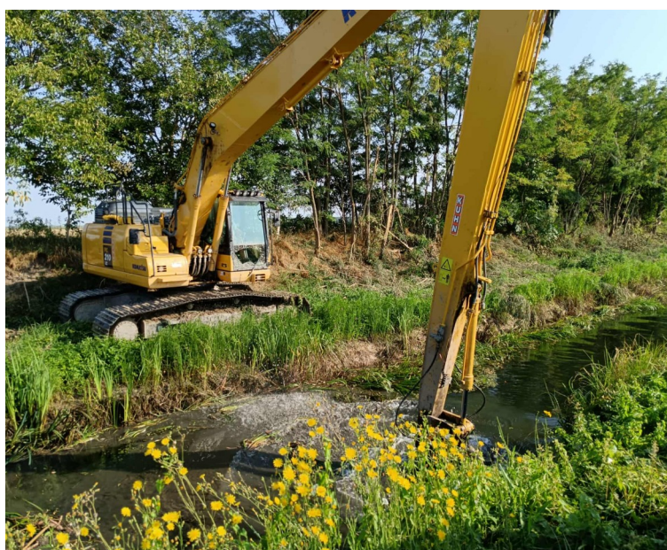
Faddi-főcsatorna, Paks — mederkotrás
