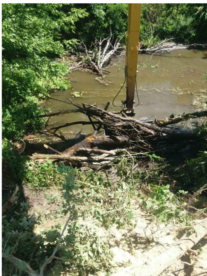
Nádor csatorna jp. 8+300-22+400 tkm Zátony és torlasz eltávolítása
