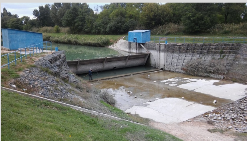
A régi elbontott duzzasztó műtárgy képei
