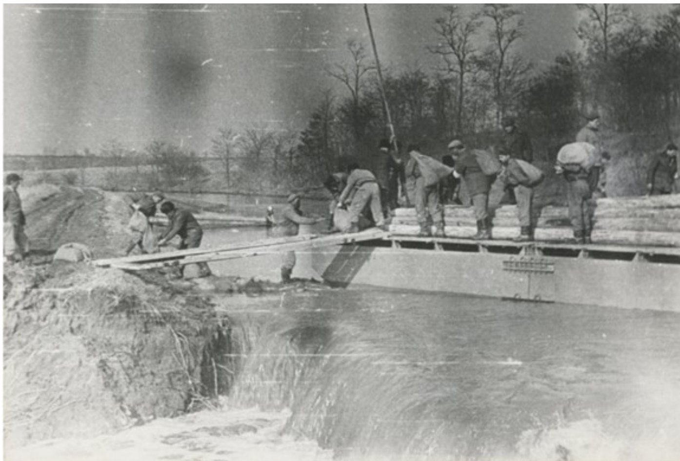
Adony-Északi-övcsatorna töltésszakadás elzárása 1963-ban
