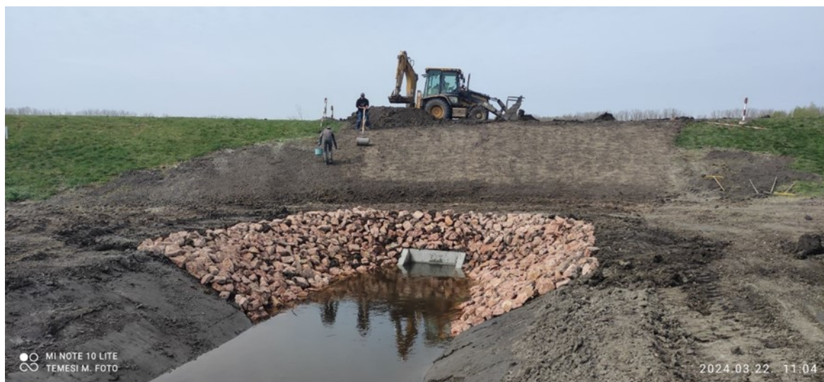
1. kép Az elkészült átkötő csatorna alvízi oldala
