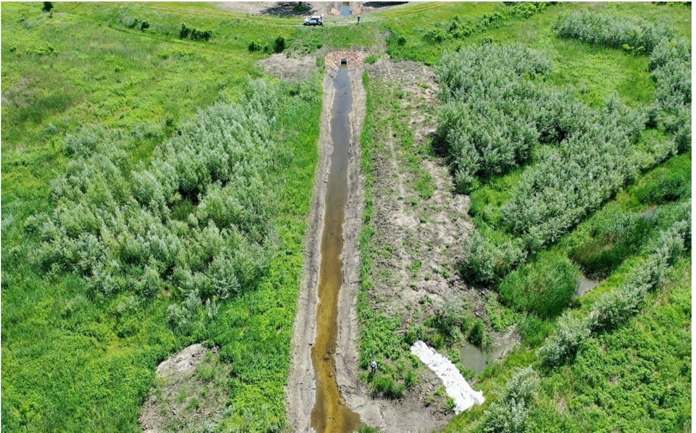
Az ideiglenes átkötő csatorna és a szivárgó árok
