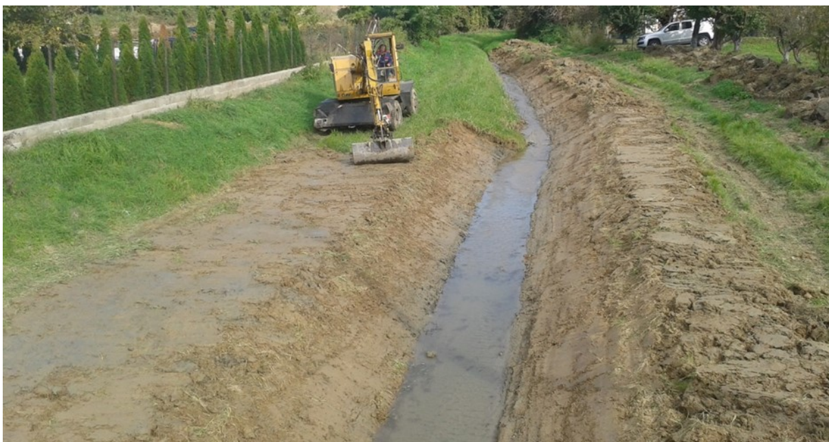
Fotó: Széles-víz iszapmentesítése (2018. év)
