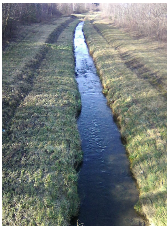
Fotó: Torna-patak feliszapolódott medre
